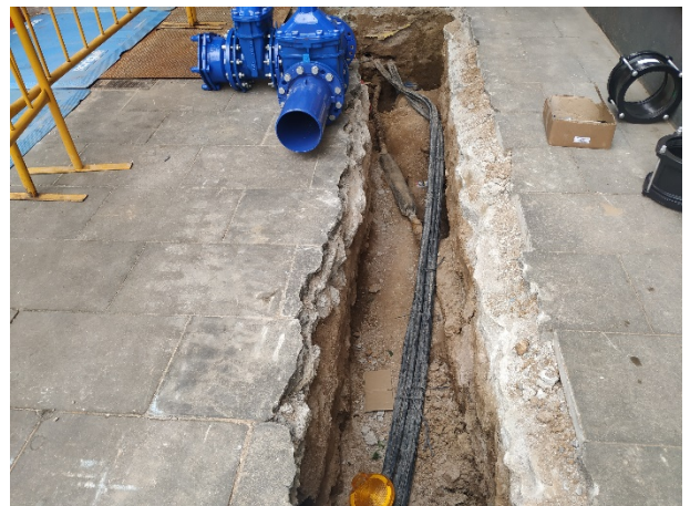
12. Detall dels serveis al carrer de Sant Pau.
