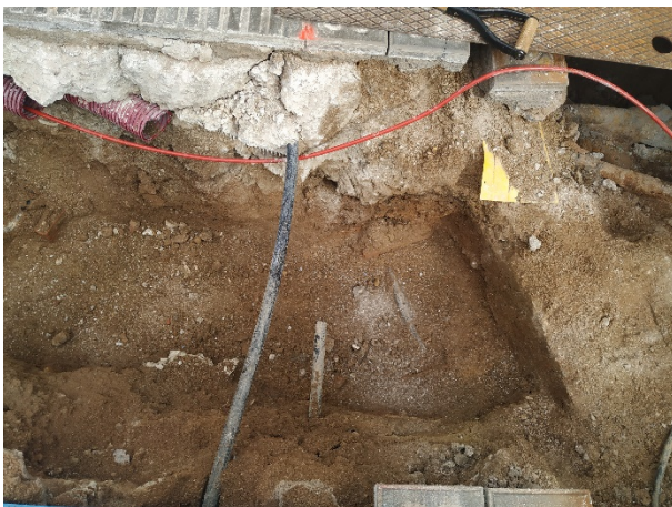
11. Vista de l'interior de la rasa a l'Avinguda del Paral·lel.
